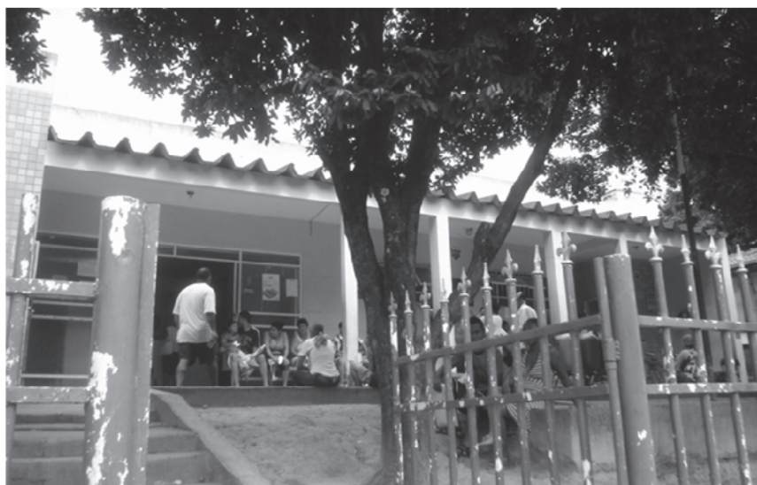
Figura 3 - Foto da entrada da UBR Jardim de Alá
